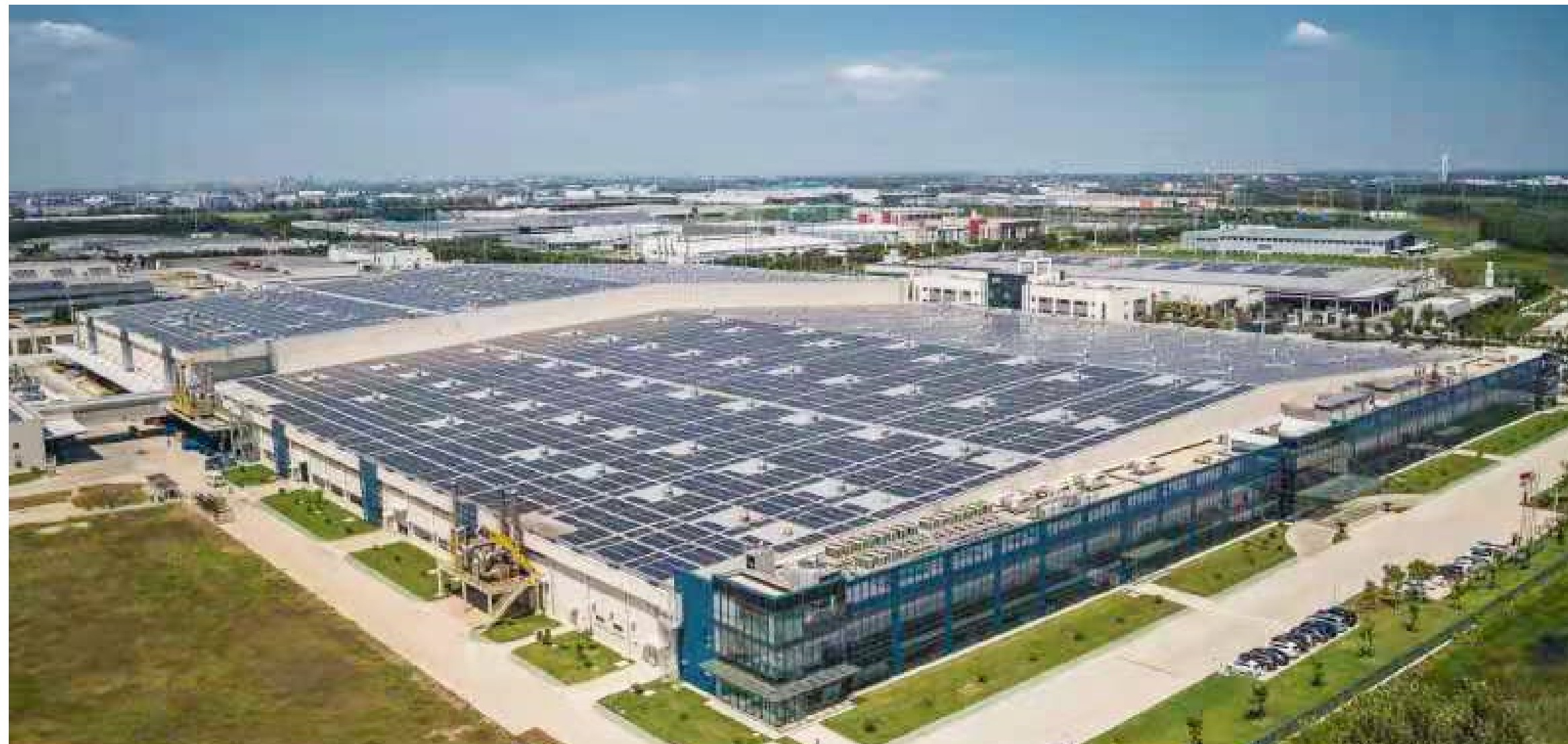
常熟工厂屋顶光伏
